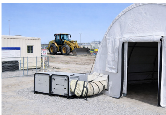
Installasjon med luftkanalene
