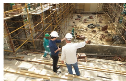
Lavori di costruzione
