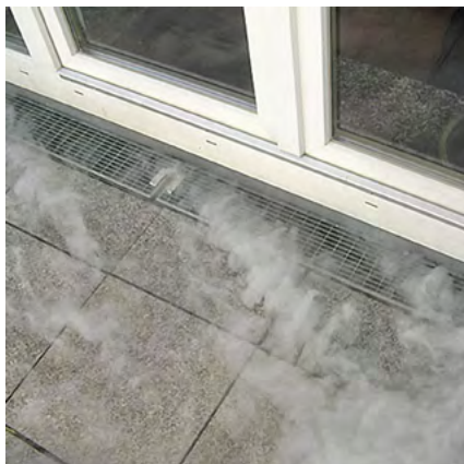
Impermeabilización defectuosa de una terraza
