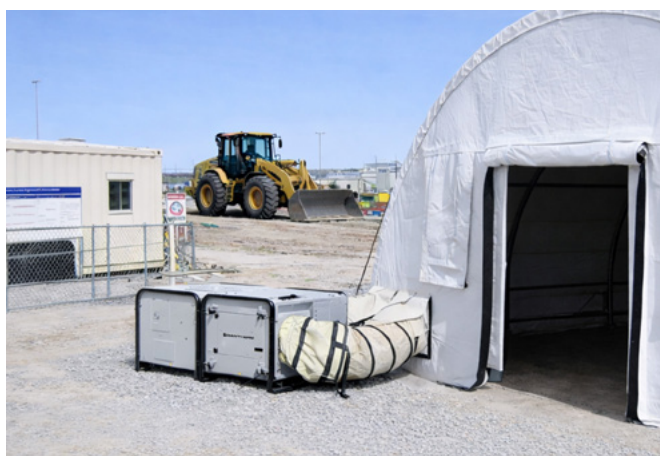
Instalación con los conductos
