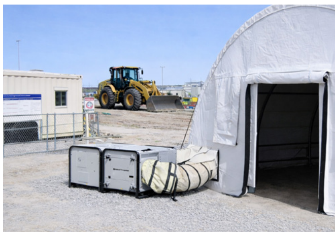
Installation med luftkanalerne
